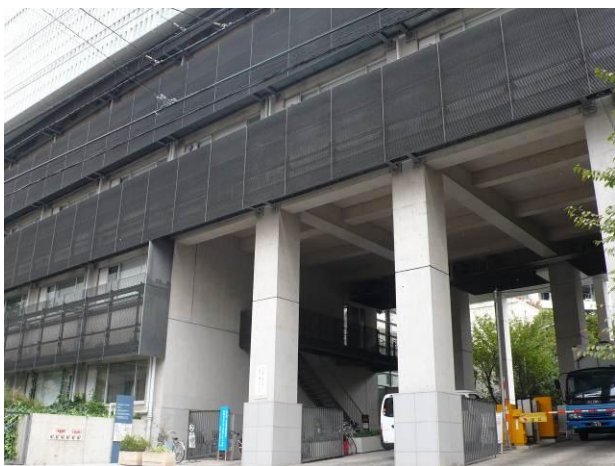
図3 東大 武田先端知ビル
