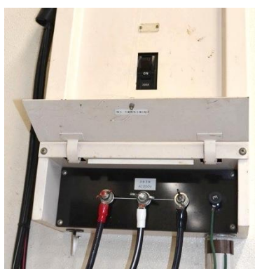
図 1 分電盤への繋ぎ込み例
