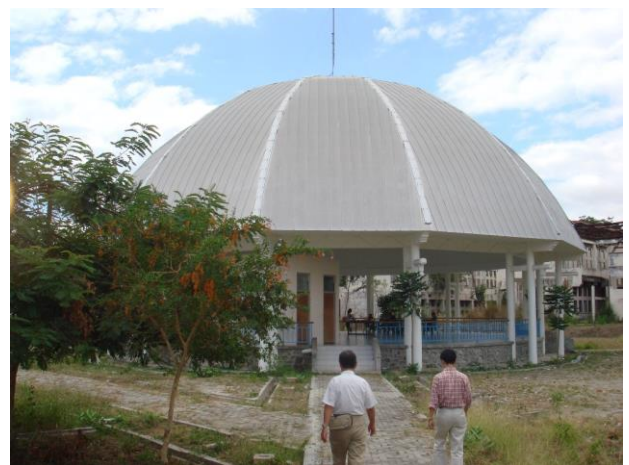
図 1 日本の援助で建てられた食堂棟
