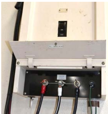
図1 分電盤への繋ぎ込み例
