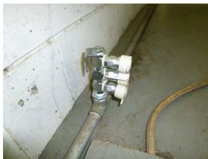
工場内エア配管の整備を行い、エアーカプラ3個口の立ち上げりを3か所新たに設置した
