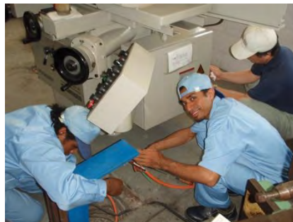
電源を繋ぎ込む
