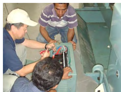
電圧 380V をトランスを介し、220V に変圧し、電源を繋ぎ込む
