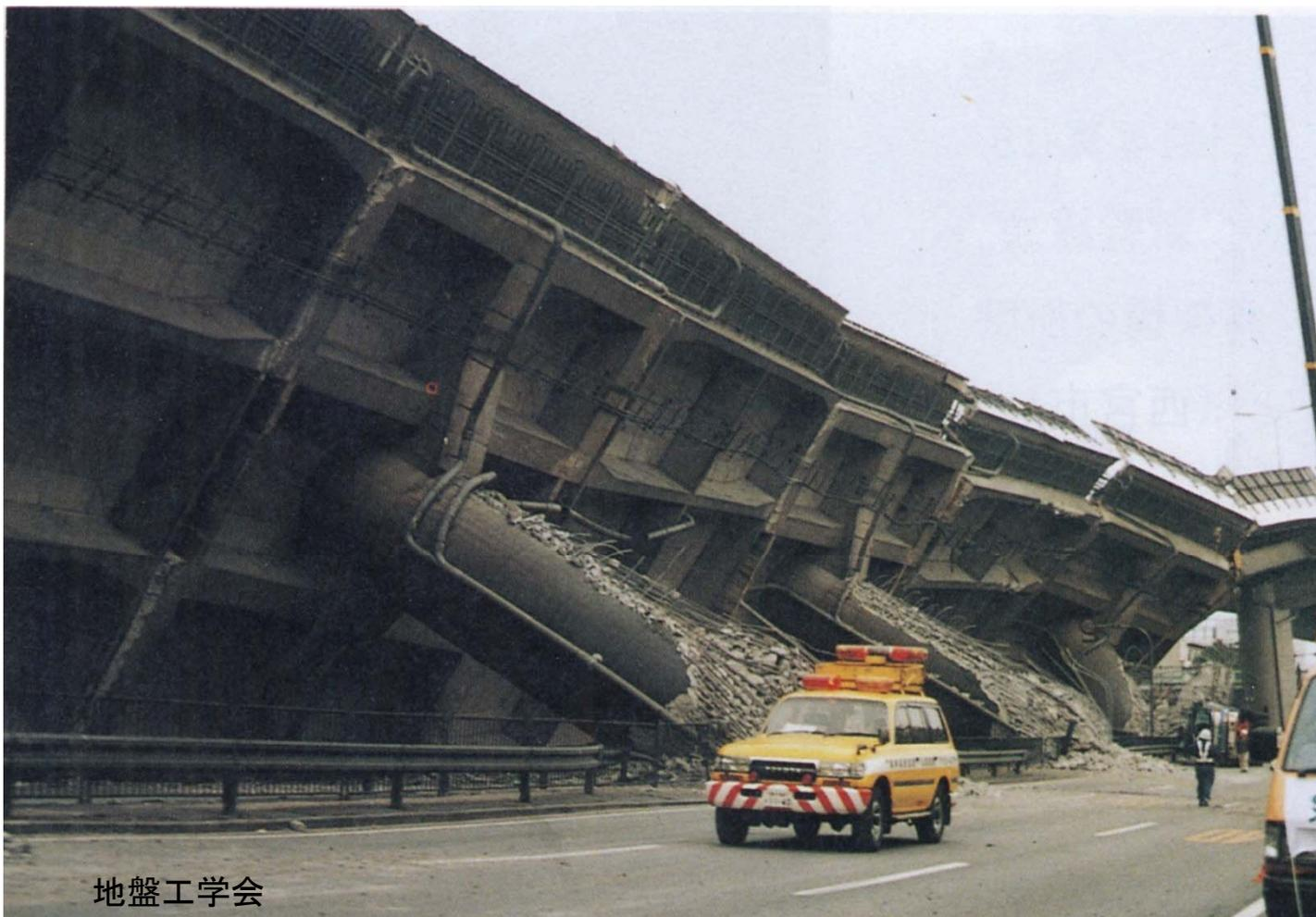
阪神高速道路の倒壊 ➡ 設計法の変更, 耐震補強
