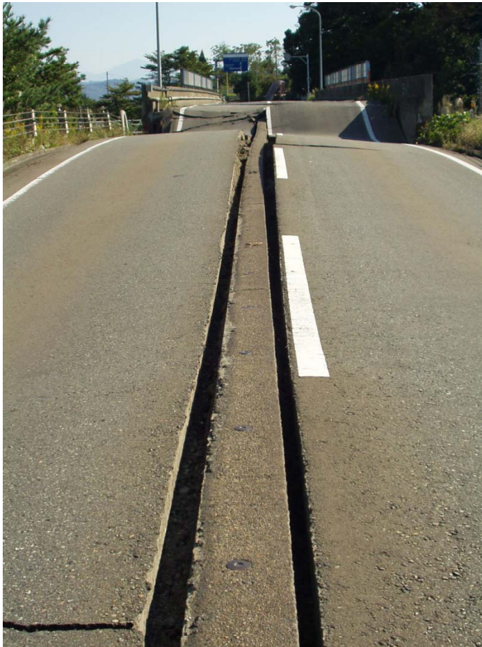
越路町のJR跨線橋盛土
