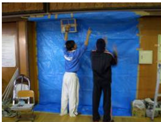
Fig.2 ビニールを貼ることで隙間風を防ぐ
