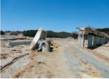
写真6 PC桁が流され、橋脚も破壊
