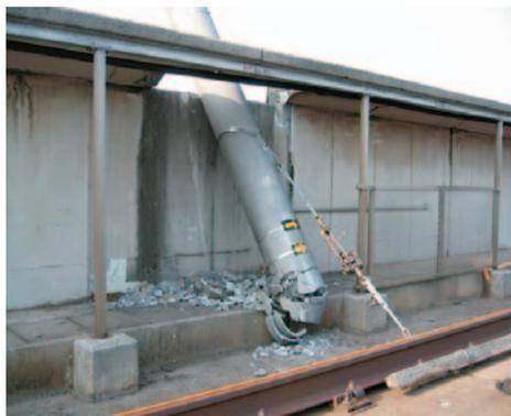
写真5 電化柱の破壊の詳細
