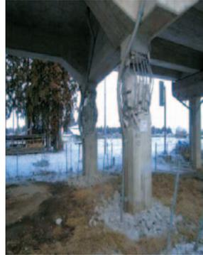
写真2 高架橋の破壊
