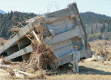
写真8 落下したPC桁
