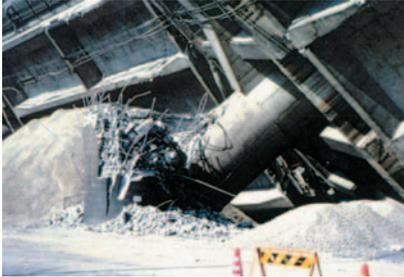
写真1 橋脚のせん断破壊
