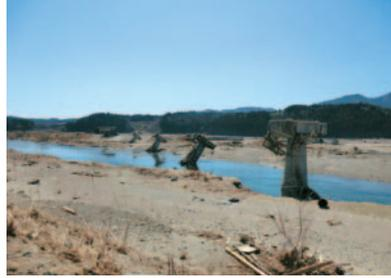
写真7 桁が流される際に傾いた橋脚
