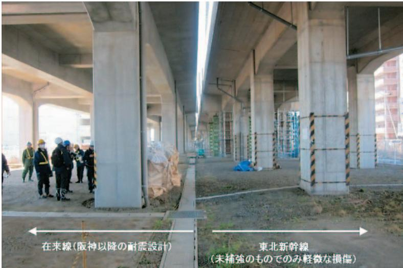
写真3 現行の耐震設計による在来線の高架橋と、以前の設計の新幹線高架橋
