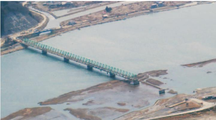
写真10 2径間のみ流失したトラス橋（新北上大橋）
